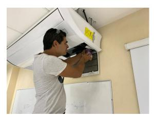
*Ilustración 26 Instalación de equipo de aire* acondicionado
