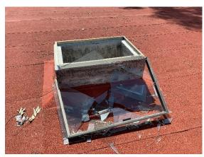
Ilustración 29 Mantenimiento a domos de Policarbonato
