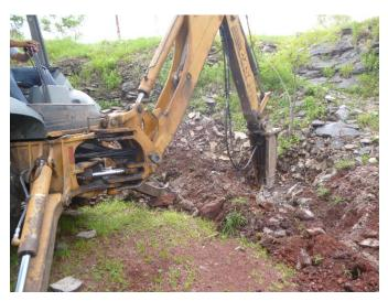
Ilustración 36 Retroexcavadora, nivelando el área circundante del Edificio "Y"
