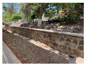
Ilustración 33 Muro de contención en canchas de basquetbol
