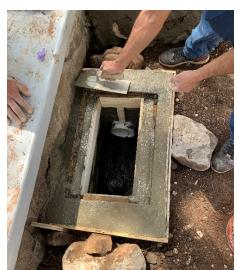
*Ilustración 28 Reparación de ductos de drenaje*
