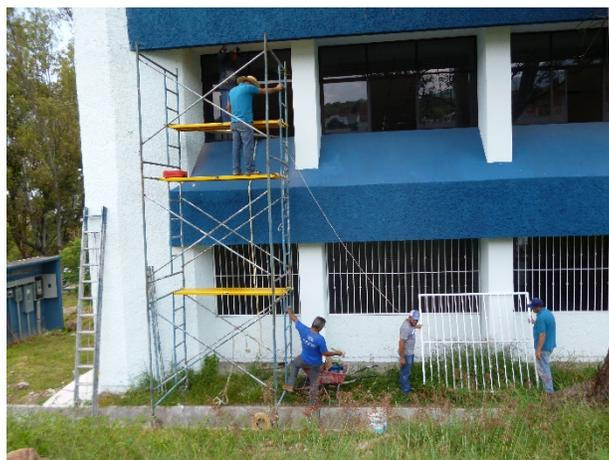
*Ilustración 61 Instalación de Protección en ventanas Edificio X*
