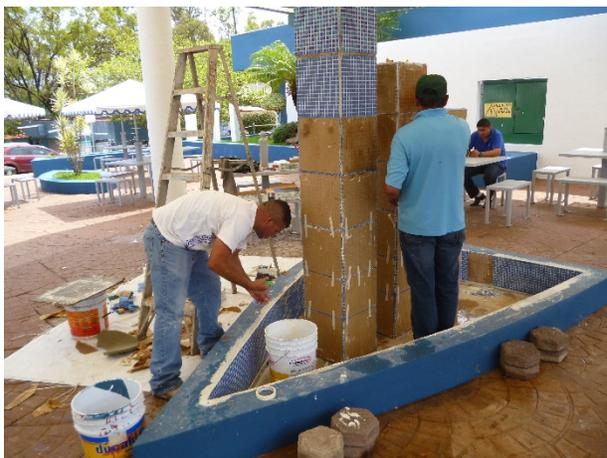
Ilustración 63 Instalación de azulejo en fuentes
