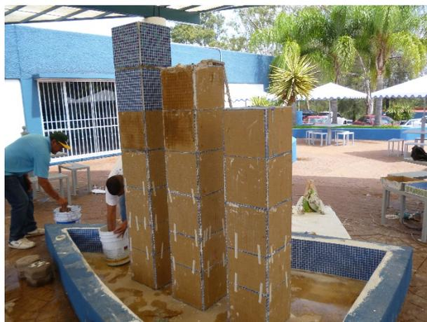
Ilustración 64 Instalación de azulejos en fuentes.
