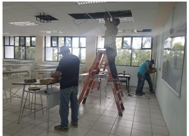
Ilustración 68 Instalación de cableado VGA para proyectores.
