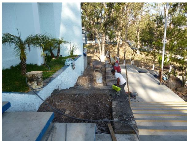
*Ilustración 59 Construcción de Machuelos.*
