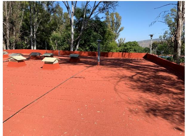
Ilustración 78 Impermeabilización de Laboratorio de Bioquímica.
