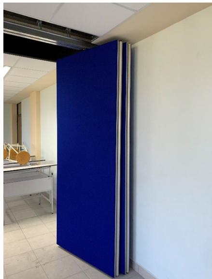
Ilustración 89 Muro acústico móvil.
