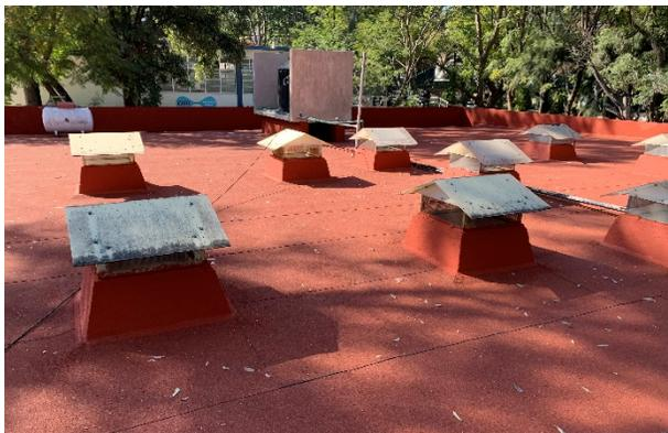
Ilustración 79 Impermeabilización de Laboratorio de Bioquímica.
