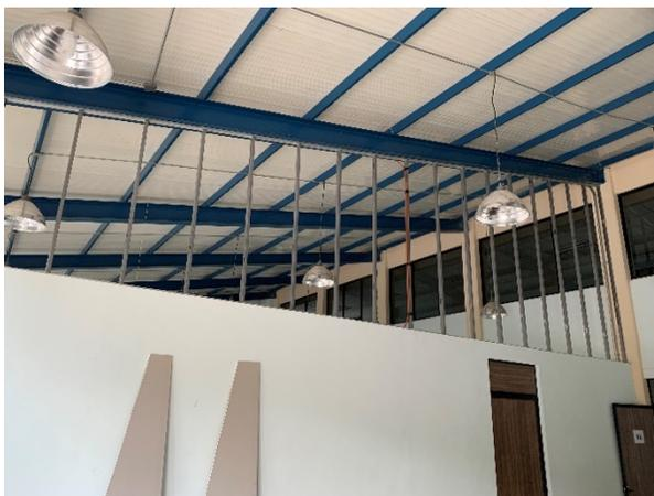
Ilustración 83 Instalación de muros de tabla roca, en edificio Y.
