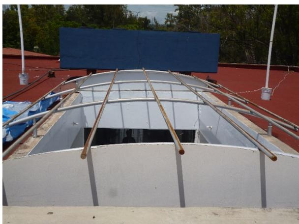
Ilustración 65 Instalación de domo, Edificio Q.
