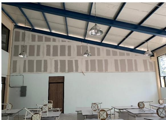
Ilustración 85 Colocación de muros de tabla roca en Edificio Y.
