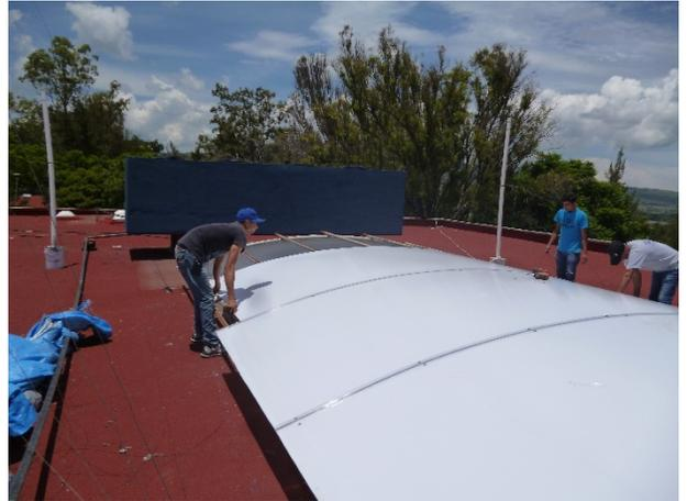
Ilustración 66 Instalación de domo, Edificio Q
