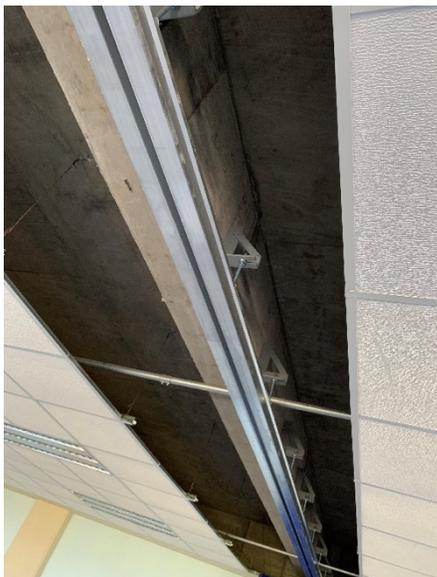
Ilustración 88 Instalación de muro acústico.
